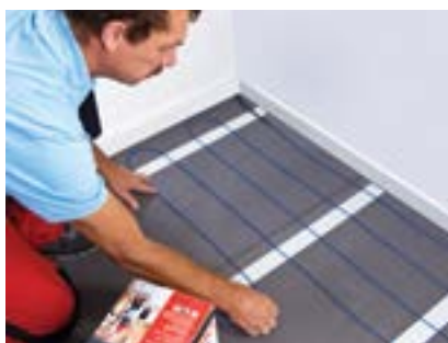
5. Fäst CeraPro-kabeln på fixeringstejpen med önskat cc-avstånd.
