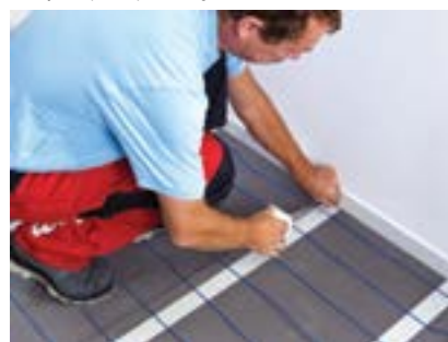
6. Säkra CeraPro-kabeln med nättejpen. 7. Fixera kabeln med smältlim vid behov.
