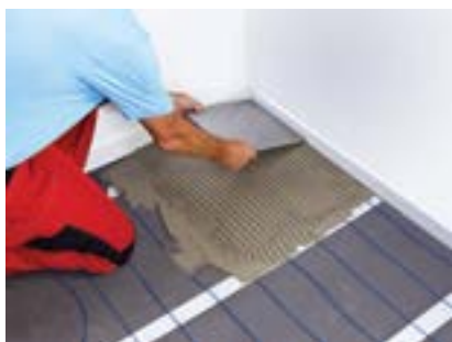
8. Täck med avjämningsmassa eller lägg klinker direkt med klinkerfix om underlaget så medger.
