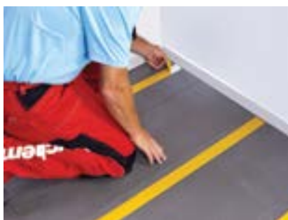
4. Fäst fixeringstejpen på golvet för att underlätta förläggningen.
