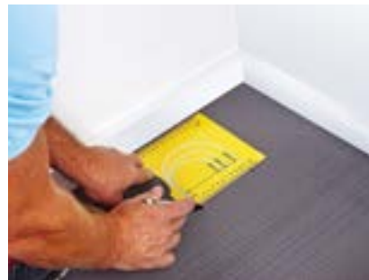
3. Märk ut önskat cc-avstånd på golvet med hjälp av linjaln på förpackningens lock.
